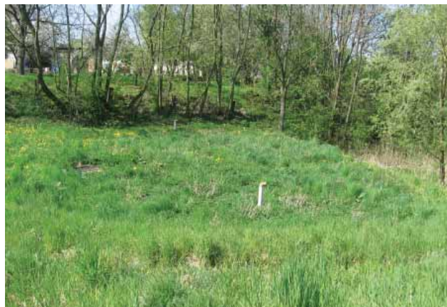
Pohled na zemní filtr. Foto archiv VÚV Praha
