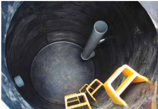
Regulační šachtice před osazením za kořenové pole domovní čistírny. Patrné je výškově nastavitelné potrubí pro regulaci hladiny a odtokové potrubí. Foto Miloš Rozkošný
