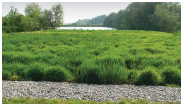
Kořenová pole osázená chřasticí rákosovitou. Porost chřastice je možné během vegetačního období kosit a přispět tak odběrem živin k lepší bilanci jejich odstranění v procesu čištění. Foto Miloš Rozkošný
