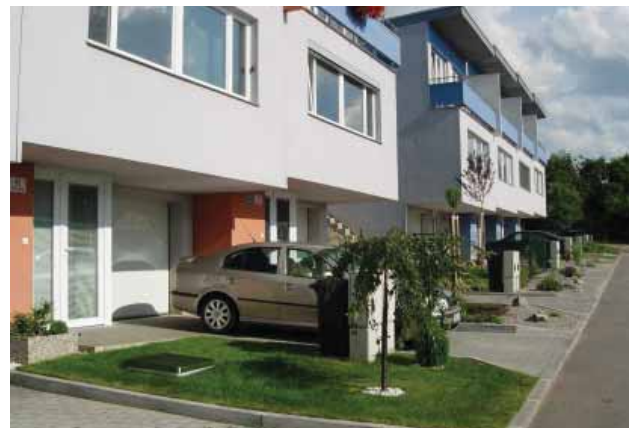
Příklad osazení kompaktní domovní čistírny v předzahrádce rodinných domů. Foto archiv USBF Technology
