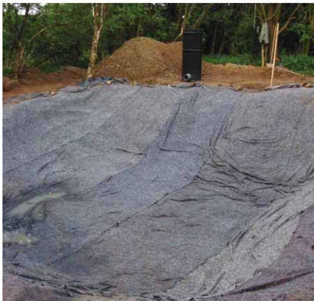
Výstavba kořenového pole domovní čistírny. Do výkopu je roztažena těsnicí fólie pokrytá ochrannou geotextilií. Foto Miloš Rozkošný
