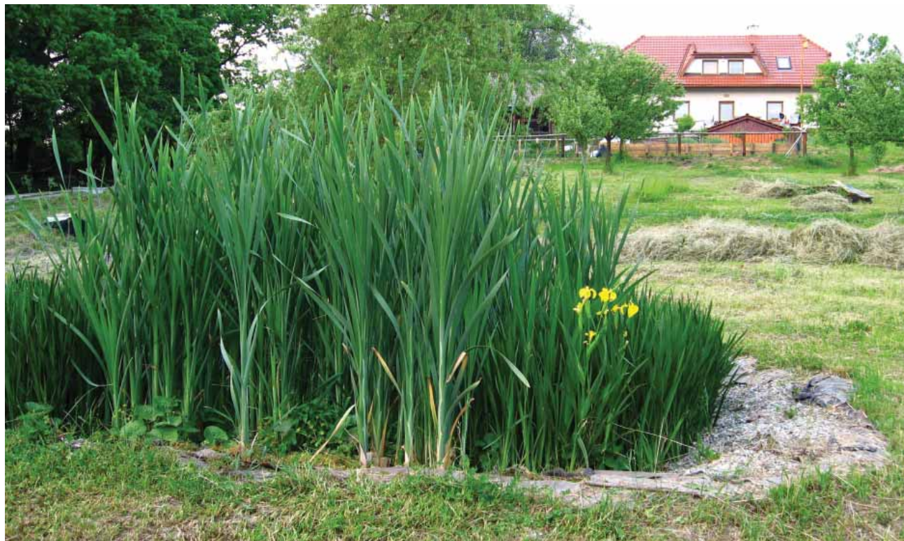
Příklad realizace domovní kořenové čistírny odpadních vod s využitím různých druhů mokřadních rostlin. Foto Miloš Rozkošný
