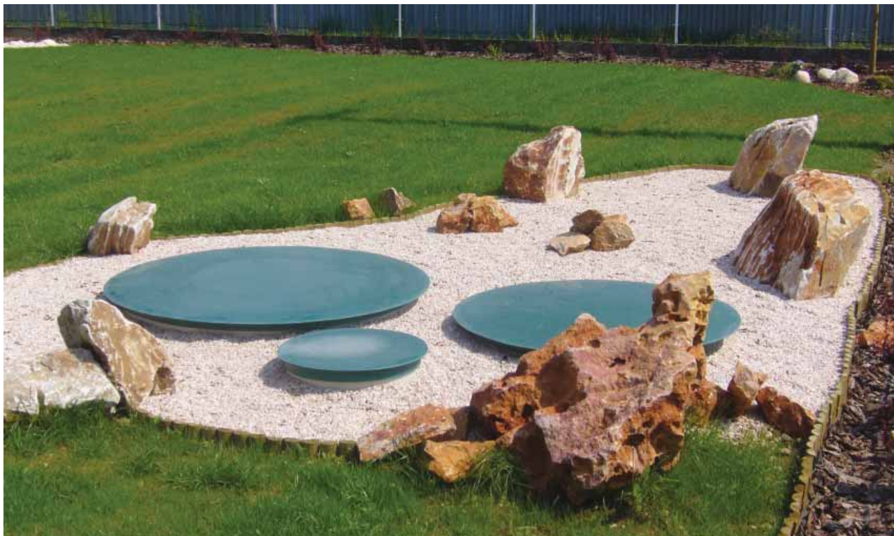
Možnost konečné úpravy a vzhledu místa s podpovrchově osazenou domovní čistírnou. Foto archiv USBF Technology
