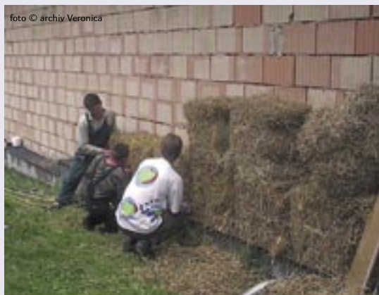
Přišívání slaměných balíků ke stěně skladu moštu.
