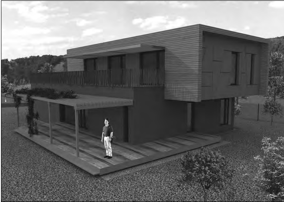
Pro pasivní domy je z hlediska tvarové optimalizace a faktoru A/V vhodné jednoduché, kompaktní „krabicové řešení“ s plochou střechou. Projekt autora – Dolní Břežany
