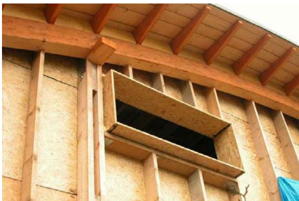
Konstrukční ostění otvorů v dřevostavbě > připravenost pro tepelné izolování tl. 300 mm minerální vlny
