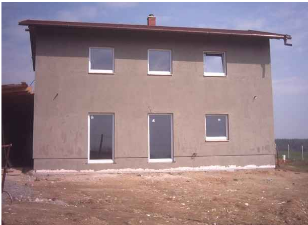
Pasivní dům jako „hobby stavba“ v Myslejevicích
