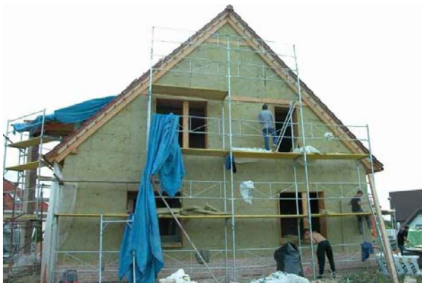
Tepelné izolování deskami z minerální vlny tl. 300 mm ve čtyřech vrstvách
