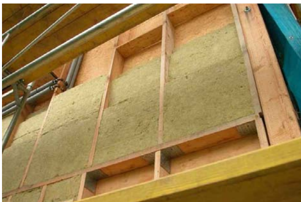
Zateplování dřevěného skeletu
