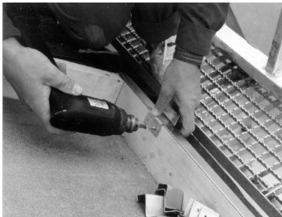
Obr. 43 Montáž háčku k uchycení skla
