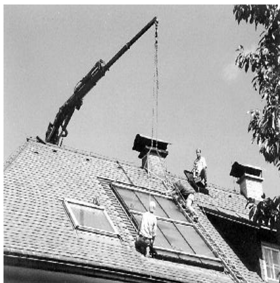
Obr. 54: Montáž zařízení o ploše 12 m 2 pomocí jeřábu za 20 minut.
