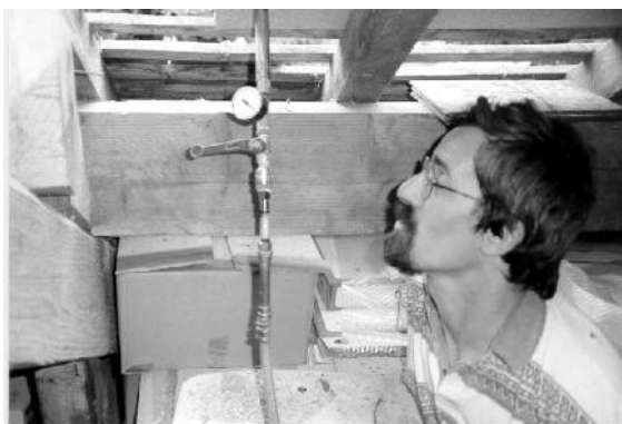
Obr. 48: Natlakovaný kolektor po uzavření kohoutu
