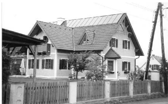
Obr. 39: Solární zařízení integrované do střechy
