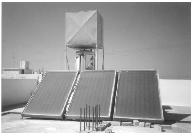
Obr.12: Samotížné zařízení pro ohřev sprchové vody (Foto: Wilk)
