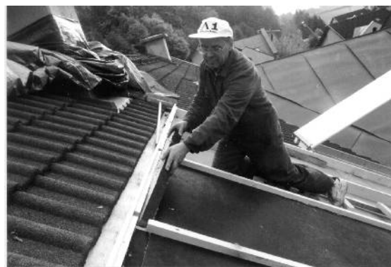
Obr. 42: Pokládání izolačních desek z černě kaširované minerální vlny
