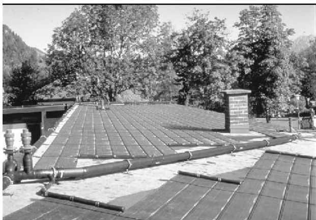
Obr.7: Absorbér k ohřevu vody v plaveckém bazénu
