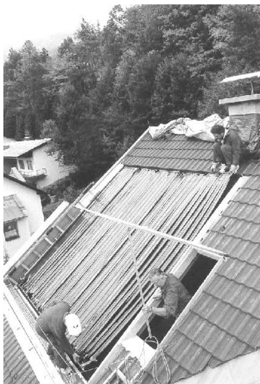
Obr. 47: Pokládání absorbérových polí
