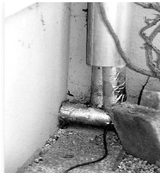
Obr. 62: Vedení potrubí okapovou rourou
