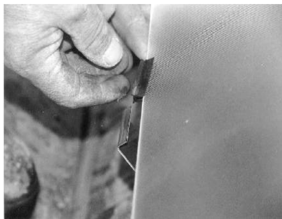
Obr. 51: Aby byla hrana skla v háčku chráněna, navlečou se na ni kousky gumových profilů
