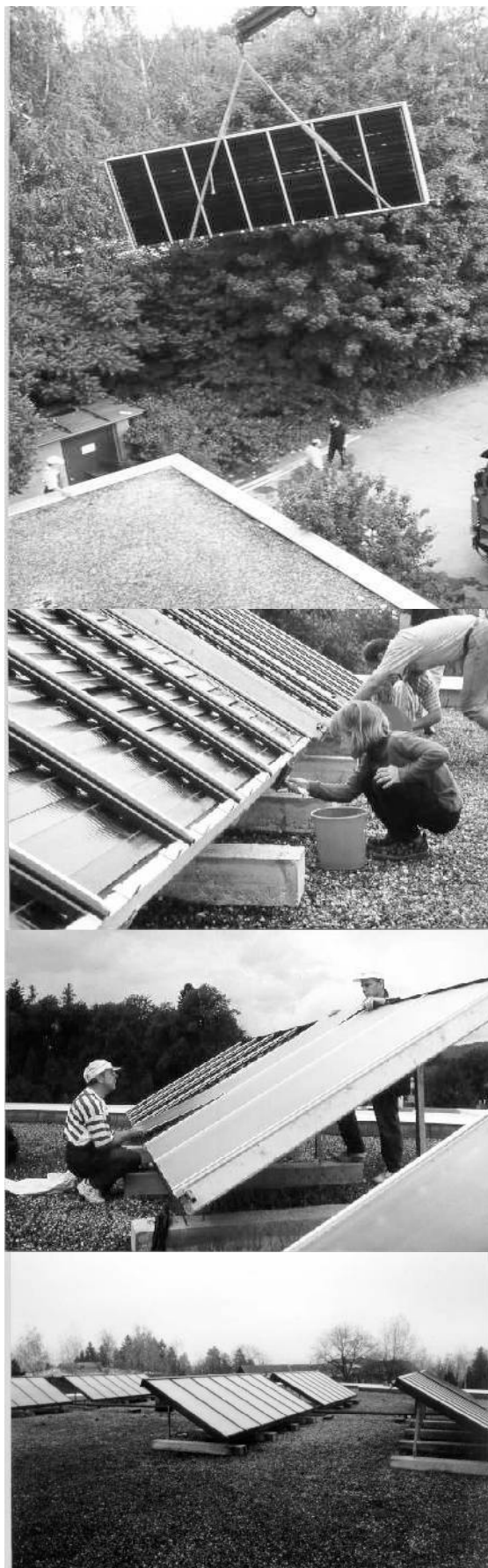
Obr. 38 a 38a: Instalace na plochou střechu ubytovny ve Villachu
