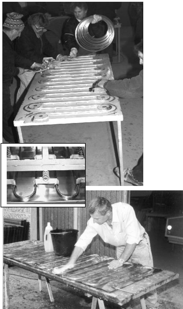
Obr.19: Příprava a sestavování kolektoru K16
